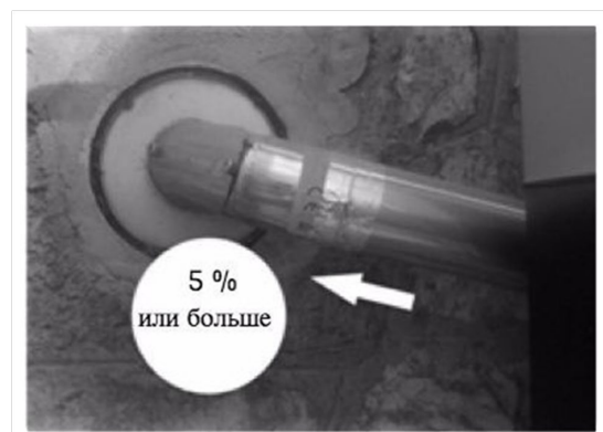
Рисунок 6. Наклон к выходу дымовых газов
